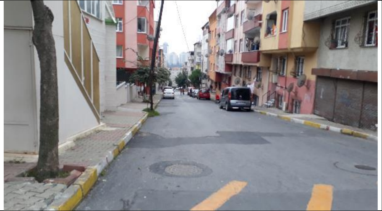
Sokak Asfaltları ve Zemine Ait Fotoğraf
